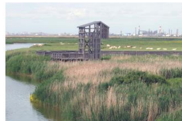
L'OBSERVATOIRE, TADASHI KAWAMATA, LAVAU-SUR-LOIRE © BERNARD RENOUX
